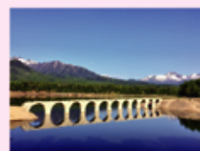
上土幌町アーチ橋
