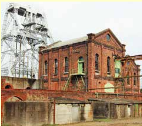
第二豎坑巻揚機室・第二豎坑籠
