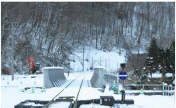
JR新得駅構内復旧工事視察（12月11日）
