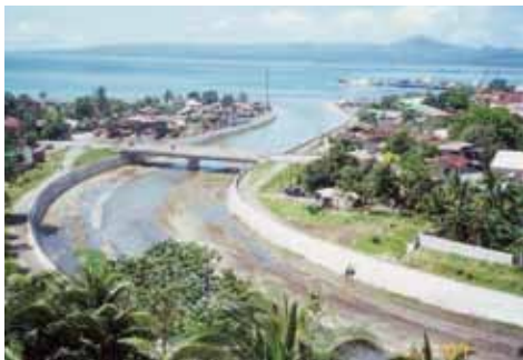
〔左〕洪水被害を抑えるため、マニラ首都圏を流れるバッシ グーマリキナ川の護岸改修を支援していく 〔右〕レイテ島オルモック市でも洪水制御事業として護 岸整備を実施
