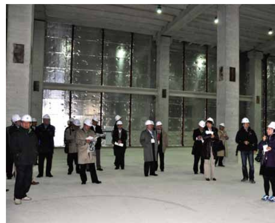
造作中の日本館のブース内部を視察
