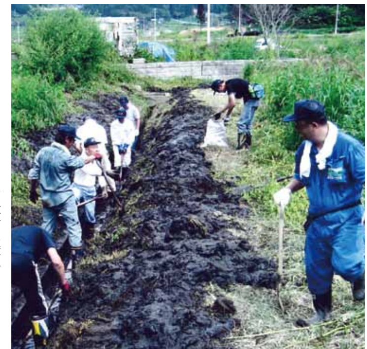
側溝水路の汚泥を除去
